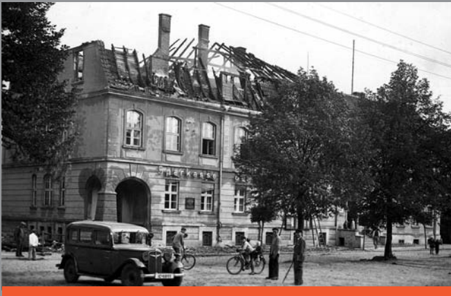
Das Hauptgebäude der Kreis Sparkasse Lebus in Seelow wurde bei einem Brand 1942 schwer beschädigt.
