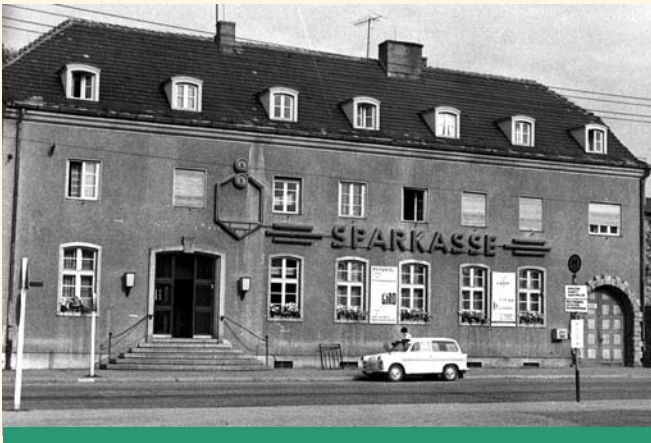
Das Gebäude der Sparkasse in Strausberg, September 1970.
